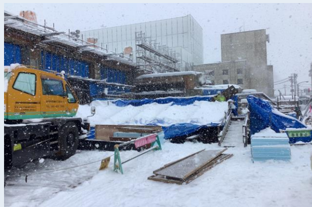
基礎工事 全景
