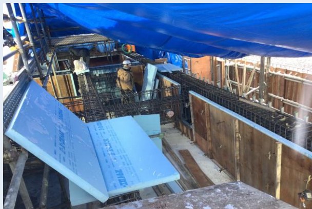
基礎配筋・型枠建込み状況
