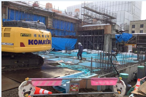
基礎埋戻し状況
