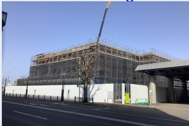
外部足場嵩上げ状況
