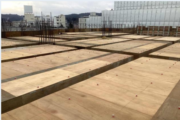
4階梁・スラブ型枠建込み状況
