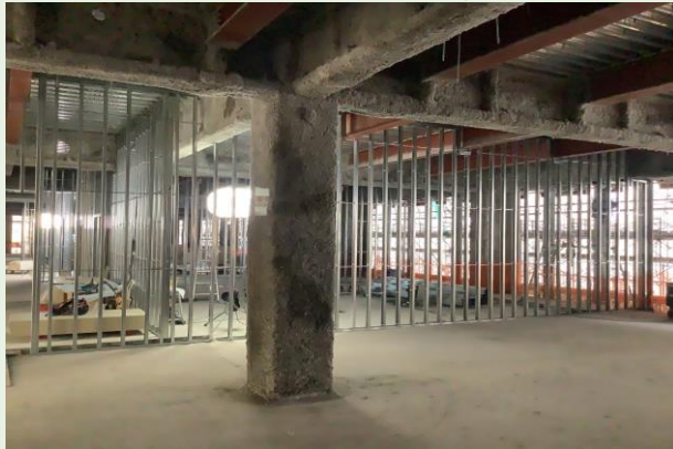
3階 壁LGS下地状況
