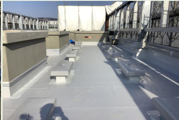
屋上 シート防水施工状況
