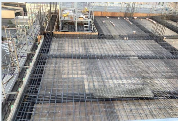
4階梁・スラブ配筋状況
