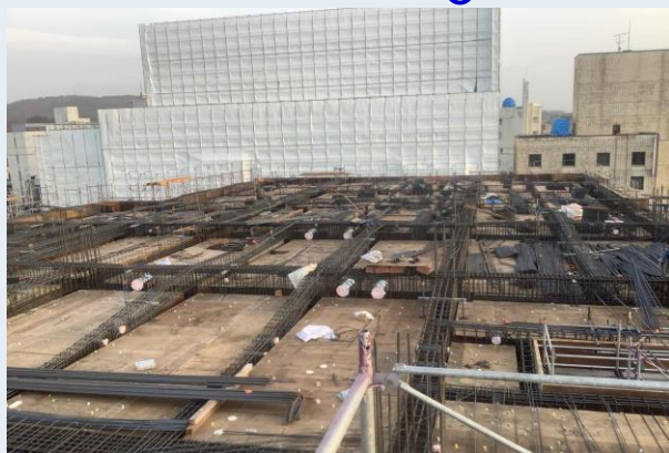
4階梁・スラブ配筋状況
