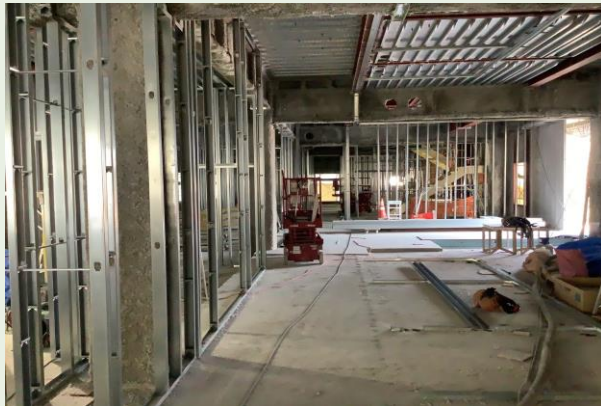
5階 壁LGS下地状況
