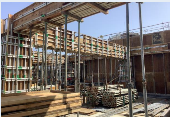
4階躯体型枠建込み状況
