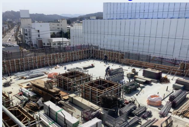
4階パラペット型枠建込み完了
