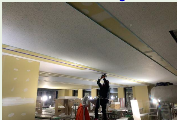
2階 天井仕上張り状況
