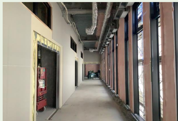
4階 ボード張り状況
