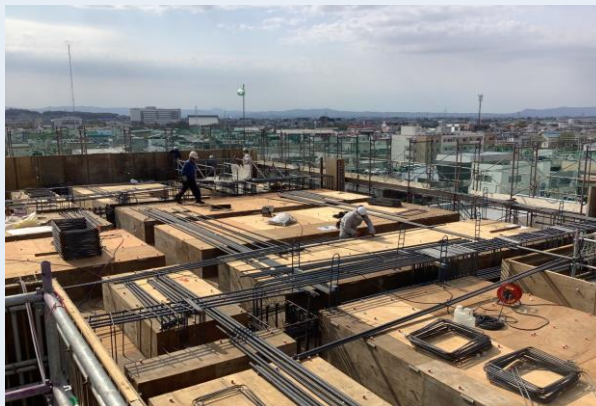
4階躯体配筋状況
