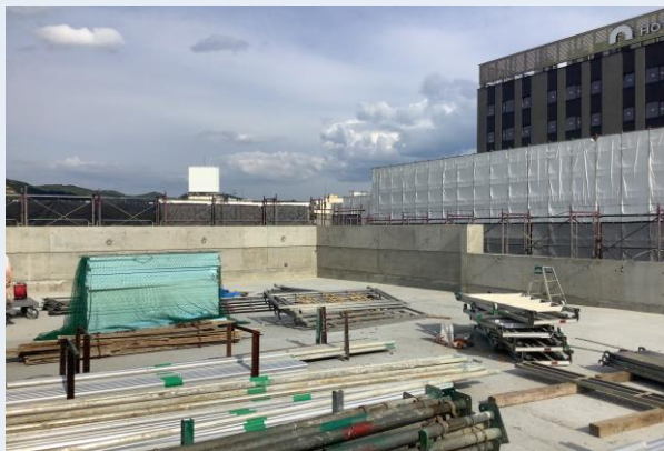
4階パラペットコンクリート打設完了
