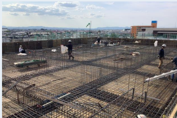
4階躯体配筋完了
