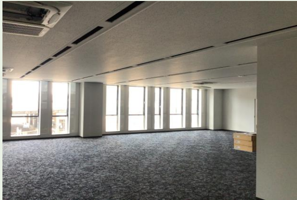
2階 電気・設備機器取付状況
