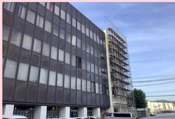
JA秋田ふるさと 足場組立状況
