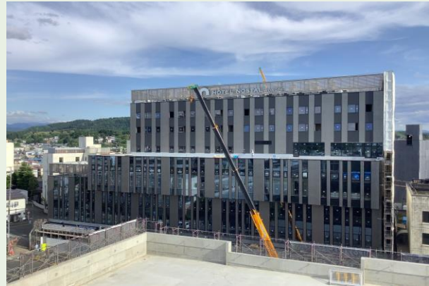
外部 北面足場解体状況
