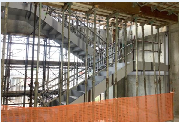
鉄骨階段設置状況
