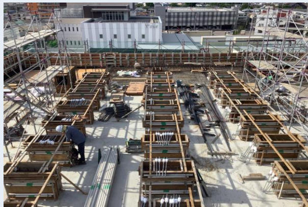
R階 機械基礎配筋・型枠状況
