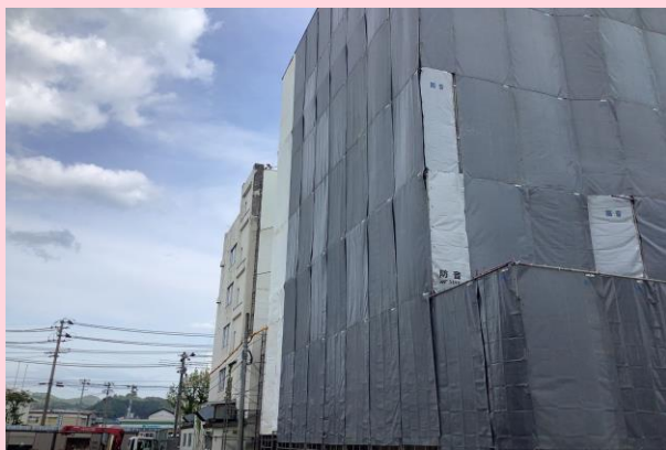
JA秋田ふるさと 足場組立状況
