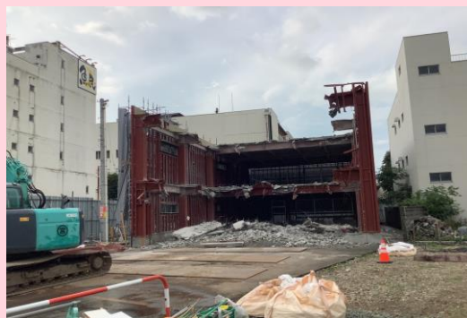
あたごビル 上屋解体状況
