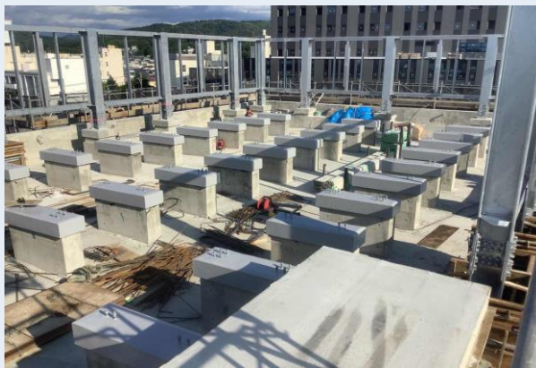
屋上機械基礎ウレタン防水状況
