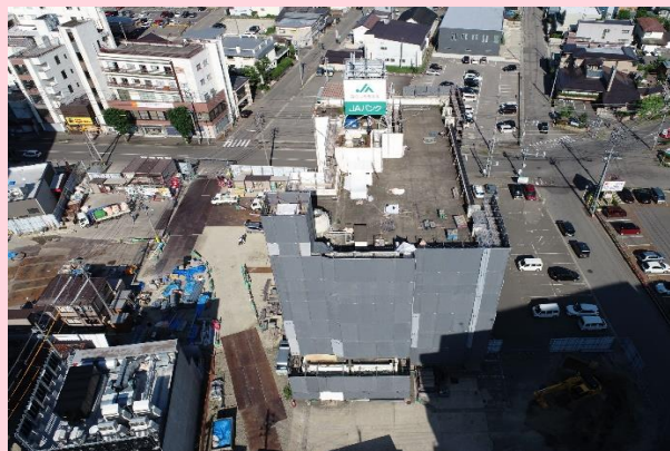
JA秋田ふるさと 外壁アスベスト除去状況
