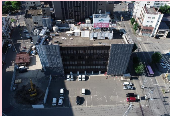
JA秋田ふるさと 屋上足場組立状況
