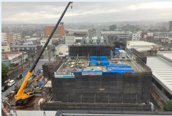
外部全景(南側より撮影)
