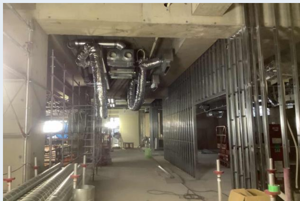
3階 天井配管・壁下地状況
