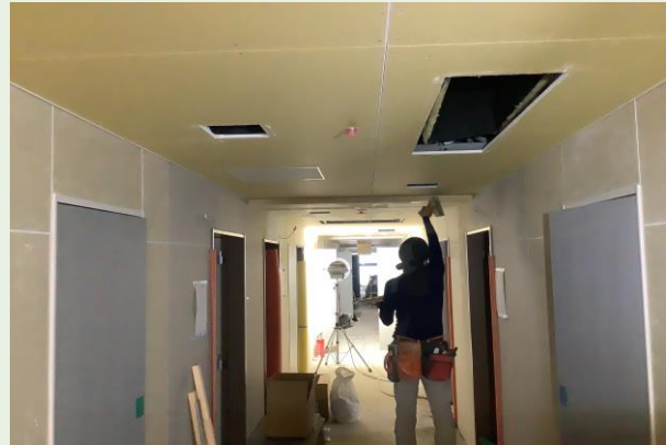
6階 クロス下地状況
