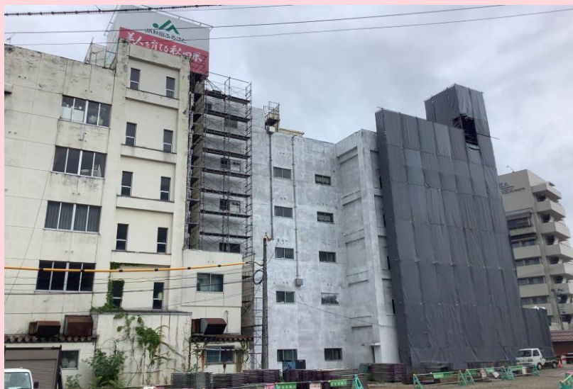
JA秋田ふるさと 北面外壁アスベスト除去・外部足場解体完了
