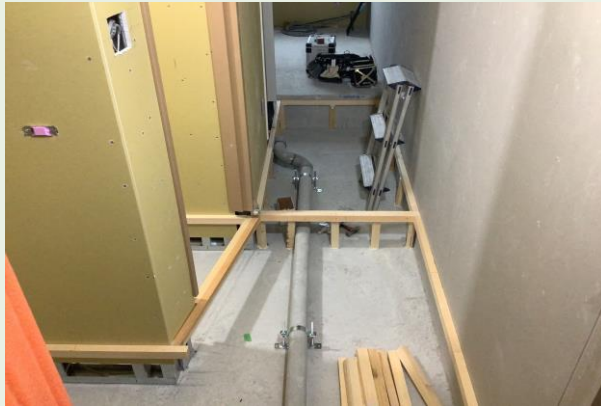
6階 置床設置状況
