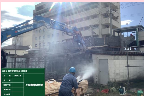
JA秋田ふるさと車庫 上屋解体状況
