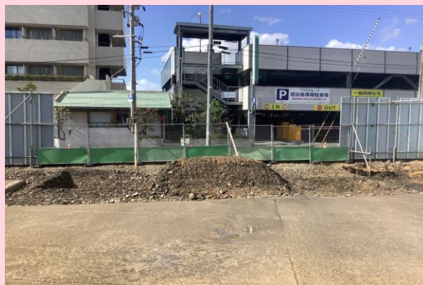
JA秋田ふるさと車庫 解体完了
