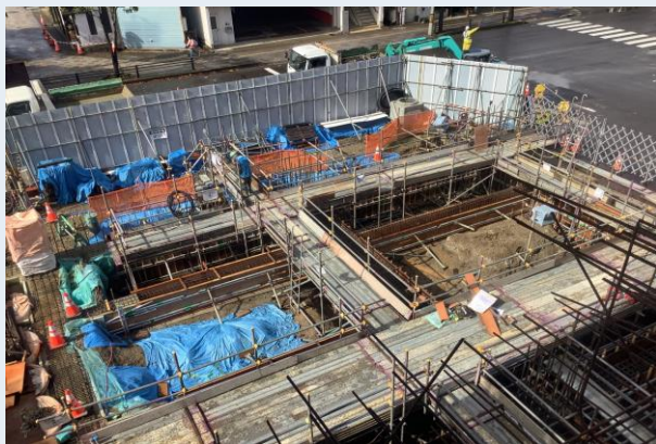
基礎配筋・型枠建込み完了
