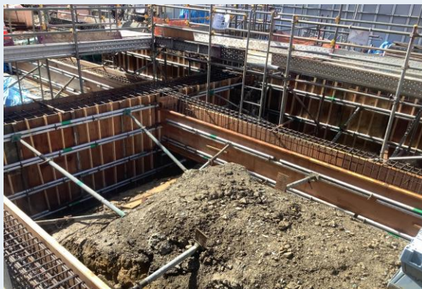
基礎配筋・型枠建込み完了
