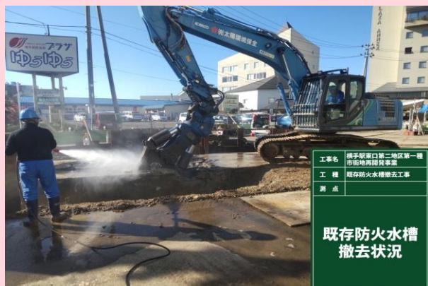
既存防火水槽 解体状況
