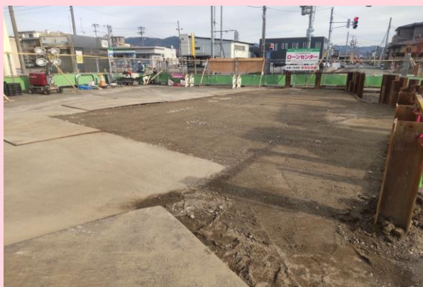
既存防火水槽 解体・埋戻し完了
