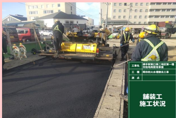
市道駅広線 舗装状況
