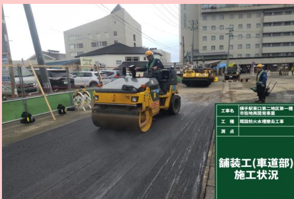
市道駅広線 舗装状況
