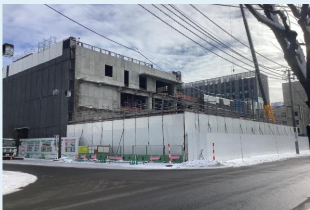
1階躯体配筋・型枠状況
