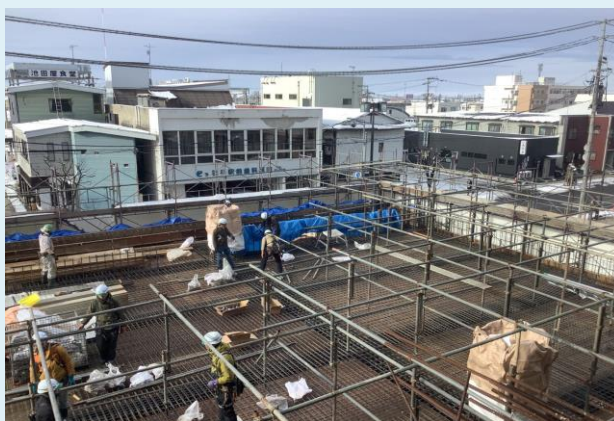
1階躯体配筋・型枠状況
