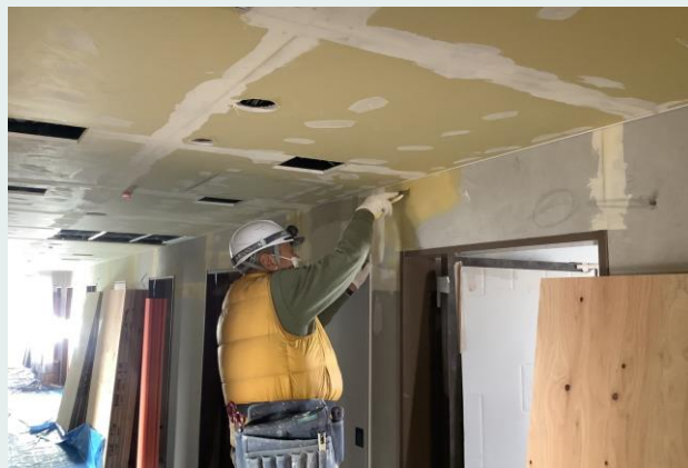
7階 天井・壁クロス下地状況
