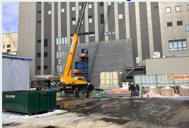
外壁アスロック撤去状況
