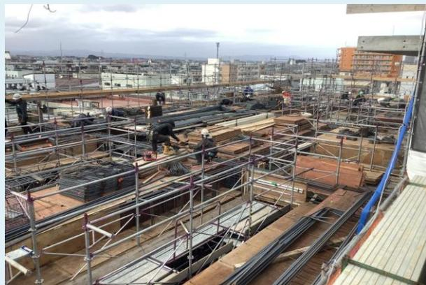
3階躯体配筋・型枠状況
