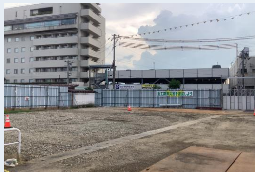
C-1棟 着工前
