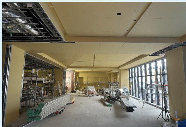
4階 壁、天井ボード張り施工状況
