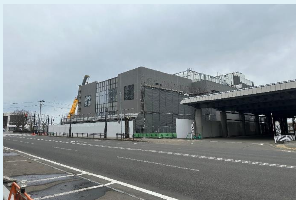
外部 南面外部足場解体状況
