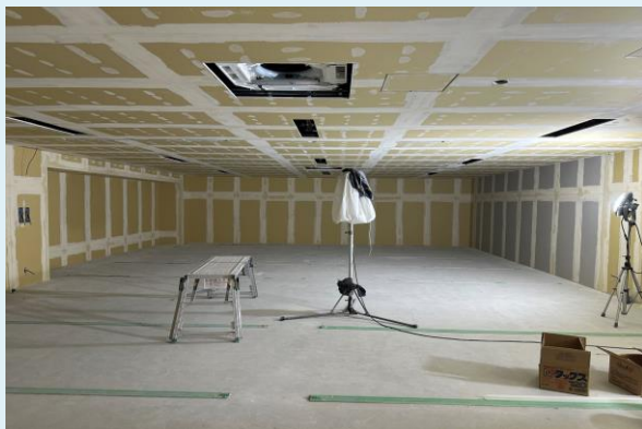
天井・壁 ビニル貼、下地処理状況
