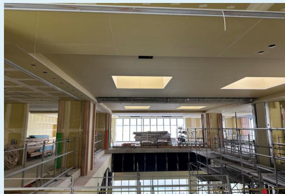
天井・壁 石膏ボード張り状況
