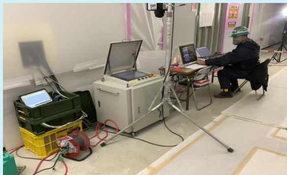
ジャッキ計測状況
