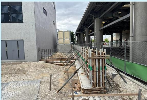
L型擁壁型枠組立 完了状況
