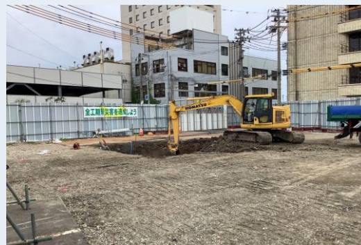
C-1棟 根切り掘削状況
