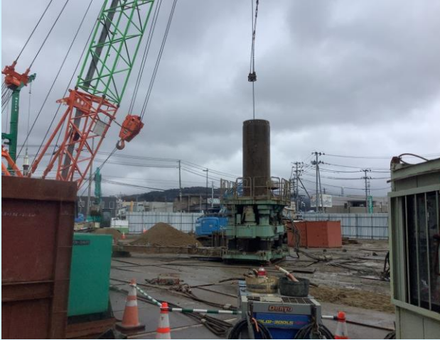
旧JA秋田ふるさと 杭引抜き状況
