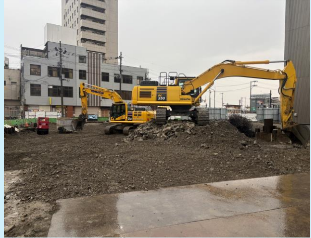
旧横手ステーションホテル 基礎・土間解体状況
