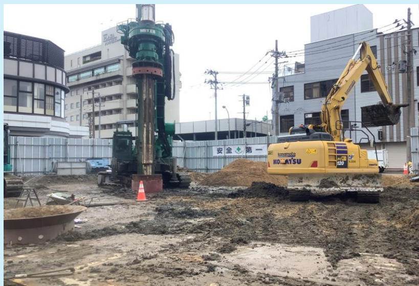
旧横手ステーションホテル 杭引抜き状況
