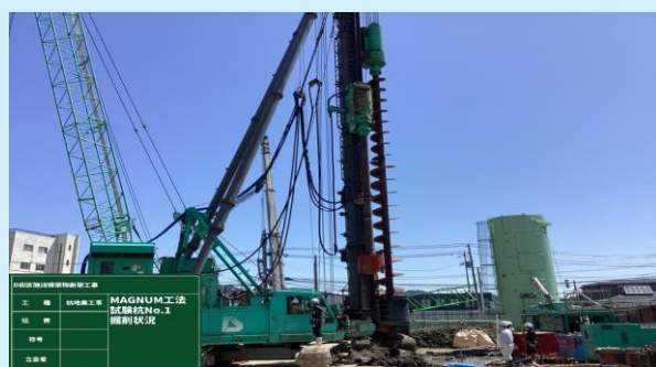
D街区 杭打込み状況
