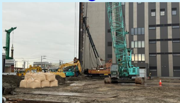
B-2棟 杭打込み状況
