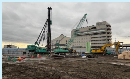
C-2棟 杭打込み状況
