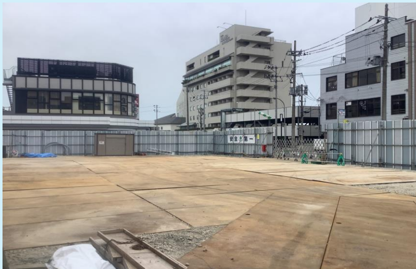
横手ステーションホテル 整地状況
