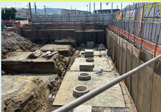
D棟 根切り状況
