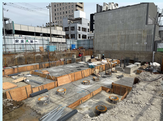
C-2棟 柱状改良状況
