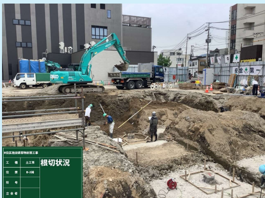
B-2棟 根切り状況
