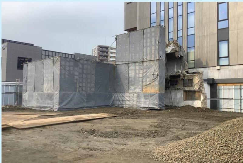
横手ステーションホテル 解体箇所
