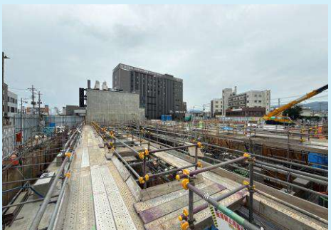
C-2棟 基礎配筋状況
