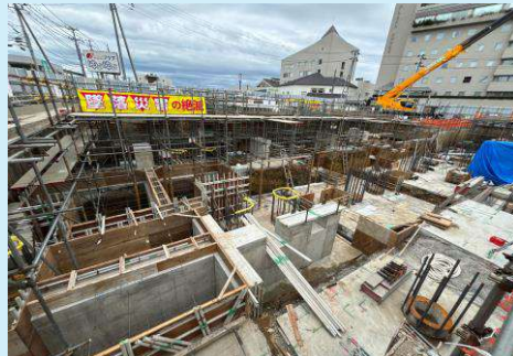
D棟 基礎配筋状況
