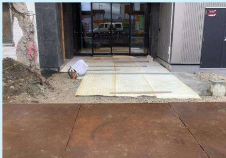
B-1棟 インターロッキング 敷設状況
