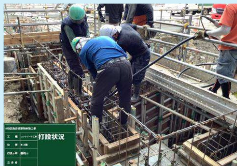
B-2棟 インター棟基礎コン打設状況
