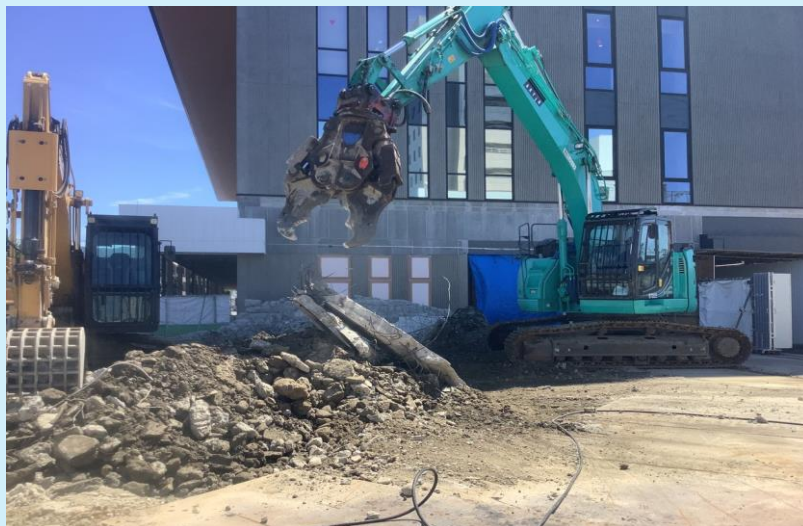
横手ステーションホテル 基礎解体状況
