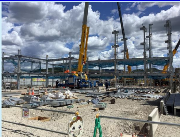
B-2棟 鉄骨建て方施工状況
