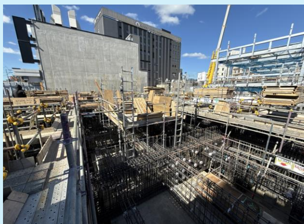
C-2棟 基礎配筋状況
