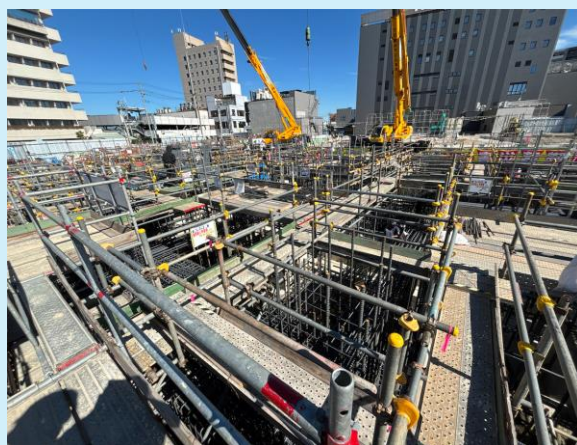
D棟 基礎配筋状況
