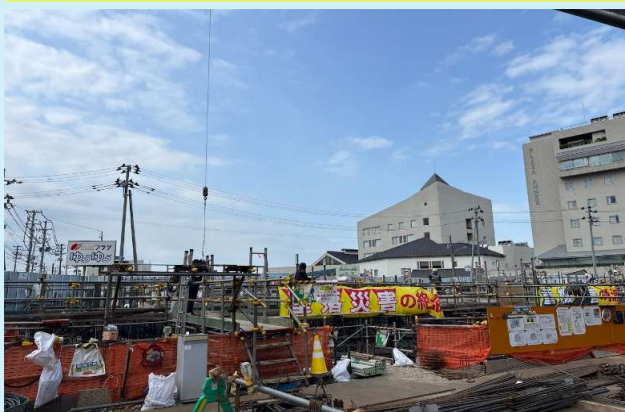
D棟 基礎配筋状況
