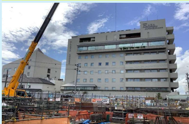
C-2棟 基礎配筋状況
