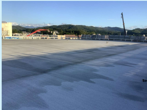
B-2棟 デッキコンクリート打設完了状況
