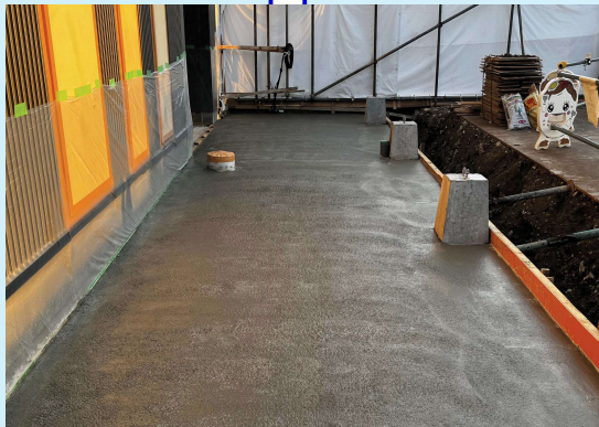
B-1棟 基礎工事状況
