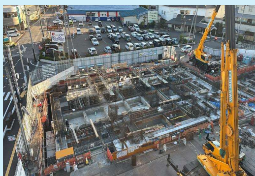
D棟 コンクリート工事状況
