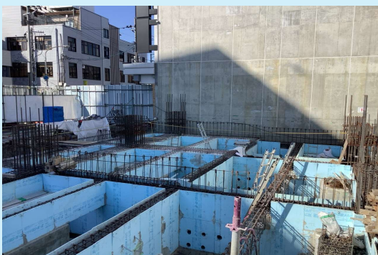
C-2棟 コンクリート工事状況
