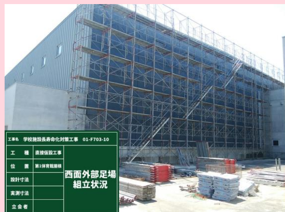
第一体育館西面外部足場組立
