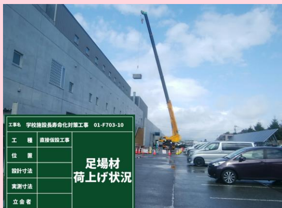
足場材荷上げ状況
