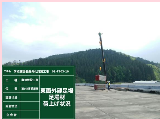
足場材荷上げ状況
