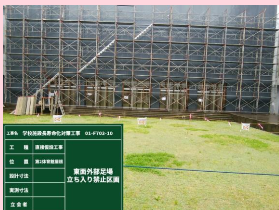
第二体育館東面外部足場組立
