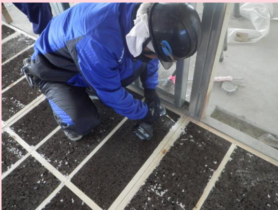
床パネル取付状況
