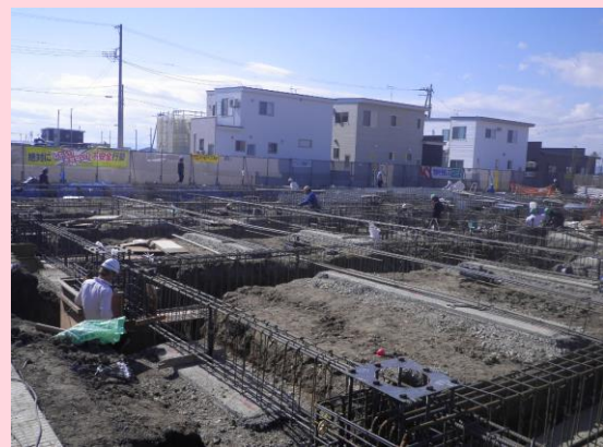
基礎配筋状況
