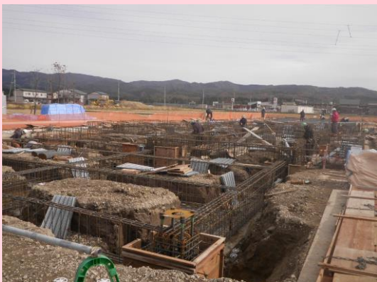
基礎配筋状況
