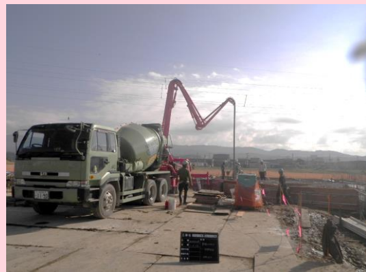
コンクリート打設状況
