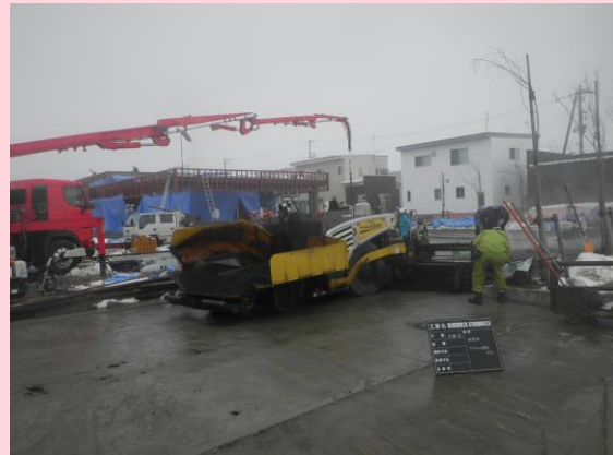
アスファルト舗装状況
