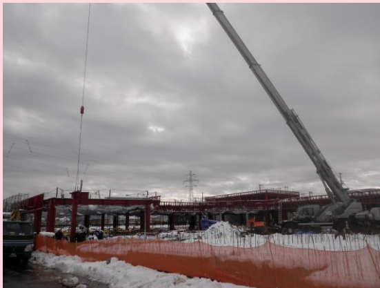
鉄骨建て方状況
