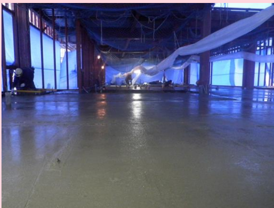
土間コンクリート打設完了
