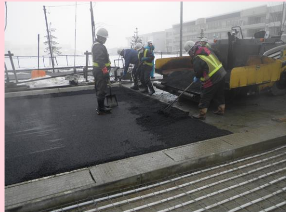
アスファルト舗装状況
