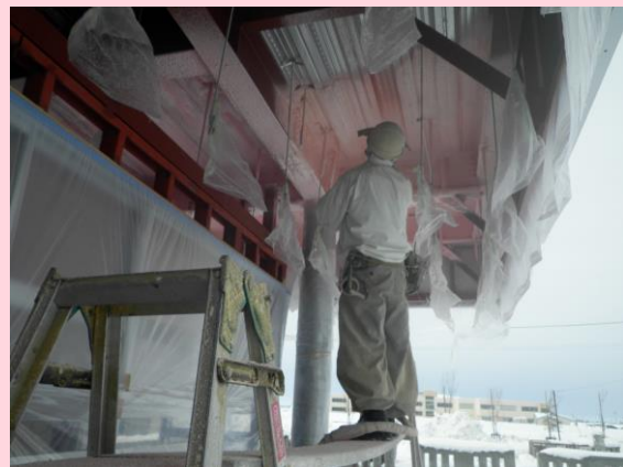
ウレタン吹付け状況
