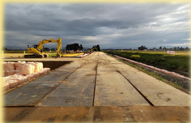
工事用道路完成
