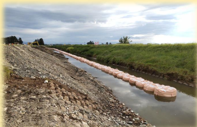
大型土のう設置状況
