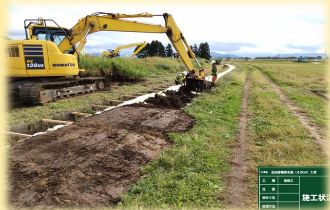
左岸工事用道路造成状況
