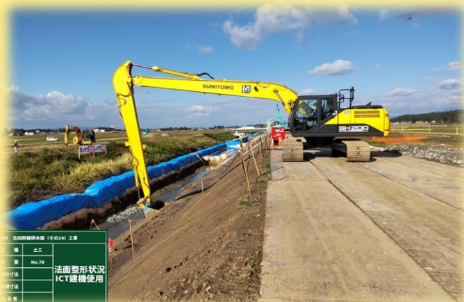
法面整形状況
