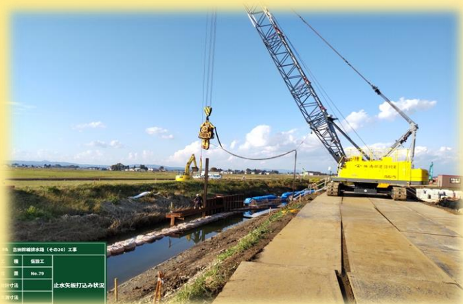
鋼矢板打込み状況
