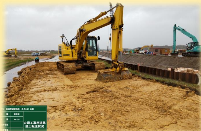
左岸工事用道路造成状況
