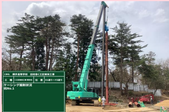
既存杭引抜き ケーシング掘削状況
