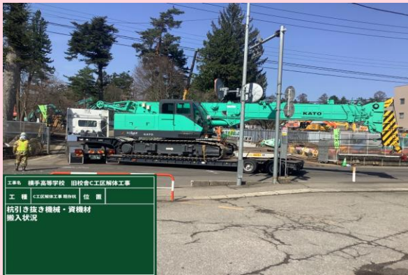
既存杭引抜機械 搬入状況
